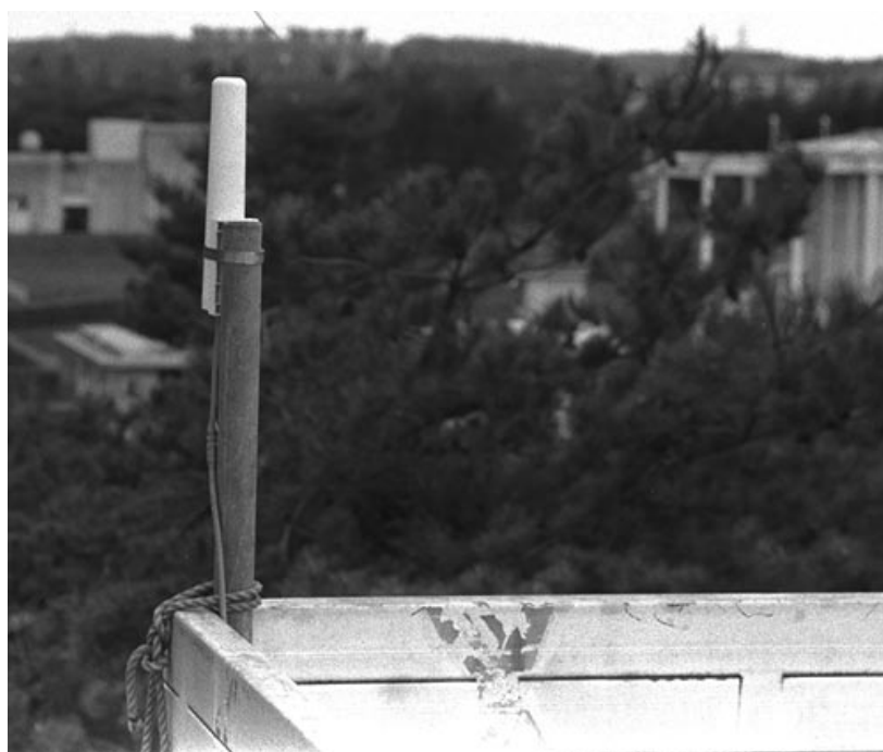
図 5.9: GN-72 アンテナ設置状況 (水沢)
