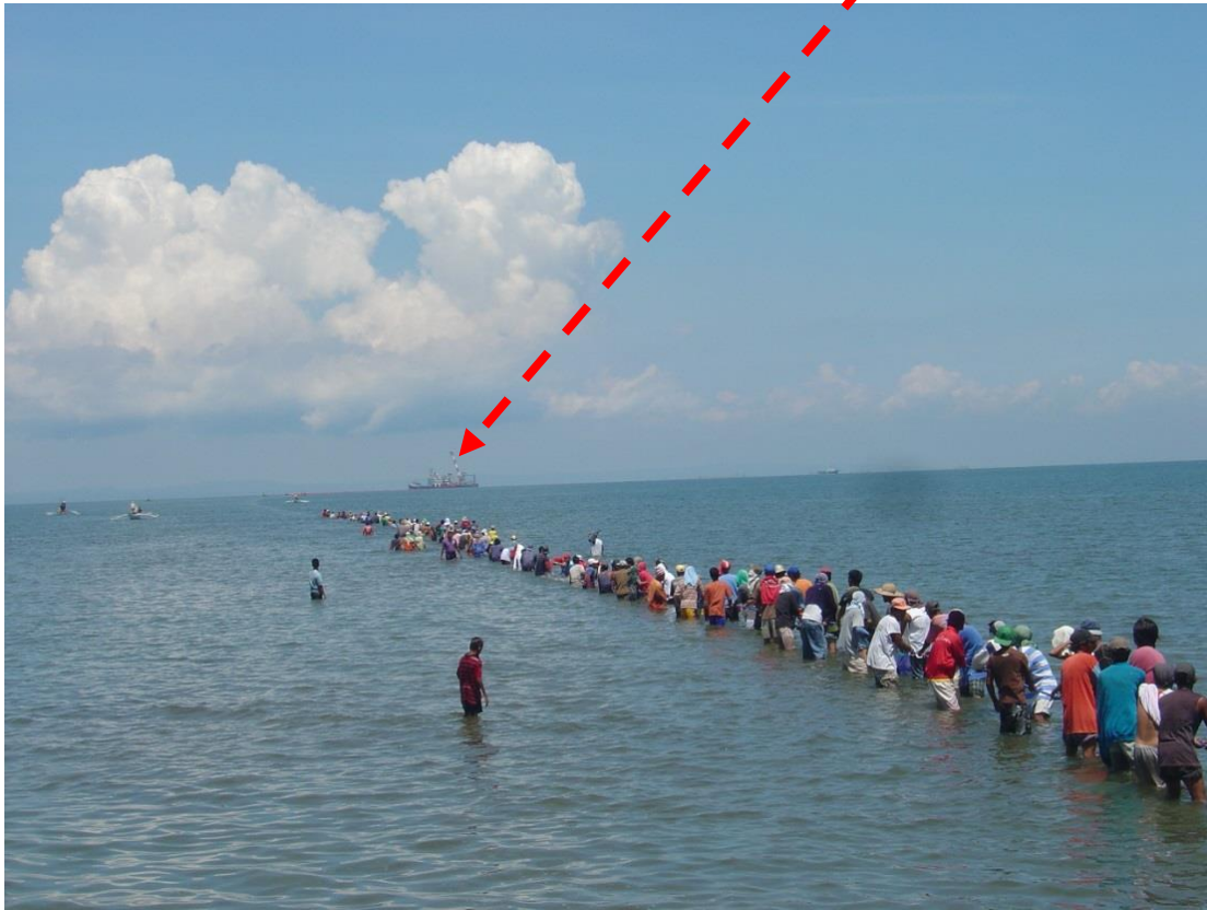
海底ケーブル敷設船
