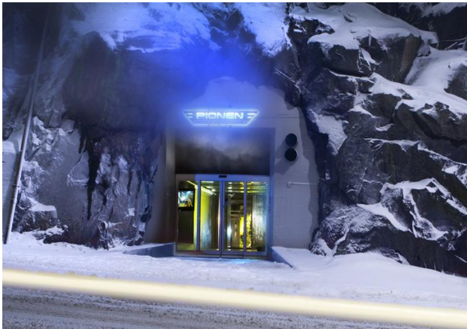
▶ データセンターの入り口
