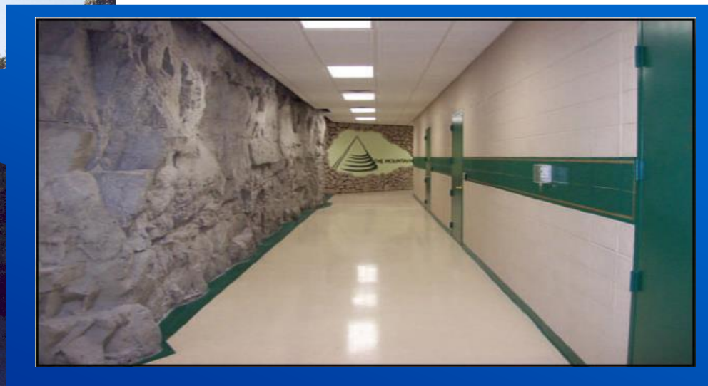
▶ 岩盤をくりぬいたデータセンター
