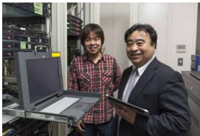
サーバールームの空調電力の省エネもコンピュータの活用で実現
