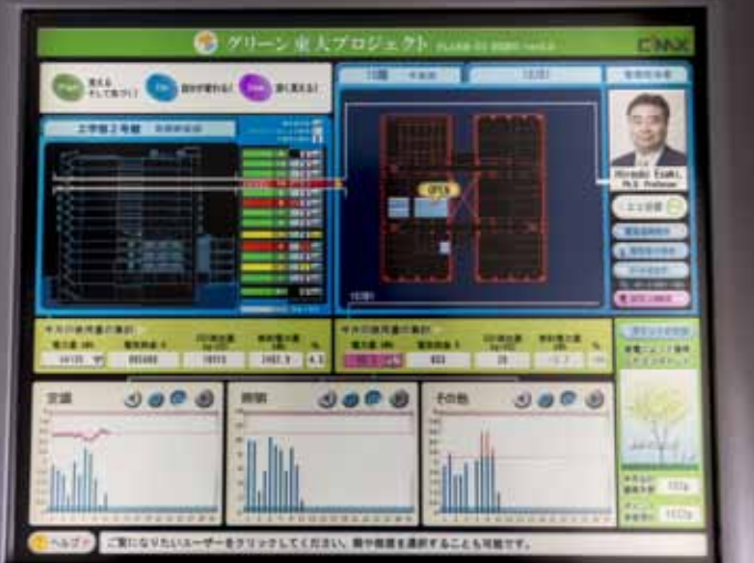
各階、各部屋の電力使用状況がオンライン、リアルタイムでわかる
