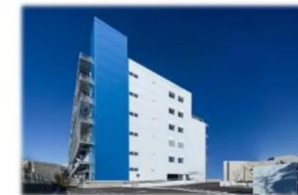
MC デジタル・リアルティの NRT12 データセンター (千葉県印西市)
